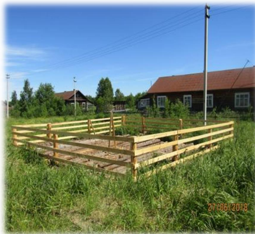
Проект: Благоустройство пожарного водоема в пос. Кудангский
